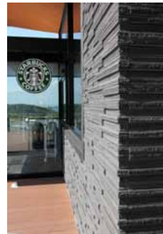
「いぶし割肌ポーター瓦」の施工例
